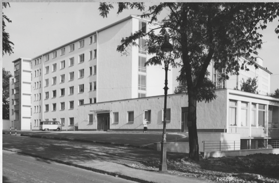
Das in den 60ern fertiggestellte August-Stunz-Heim, das sich seither auch baulich weiter entwickelt hat. Grundsteinlegung war am 24.01.1956, dem ersten Todestag des Namensgebers August Stunz.
